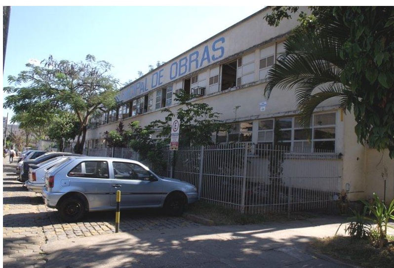
Fotografia 16 - Instalações cedidas pela Prefeitura de Timóteo para funcionamento do Instituto de Instituto de Tecnologia e Artes
