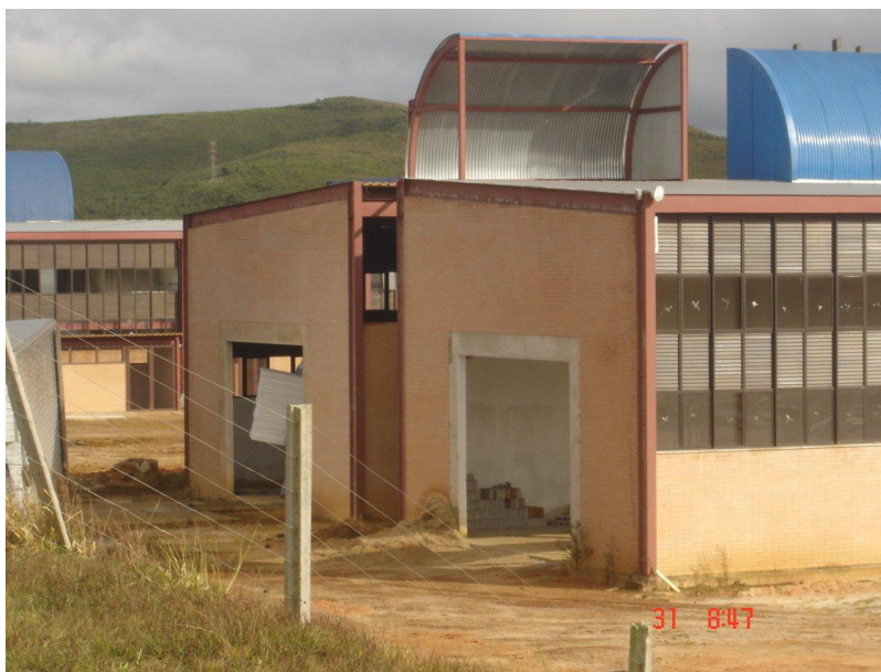
Fotografia 4 – Construção de laboratórios da Escola de Minas no Campus Universitário do Morro do Cruzeiro
