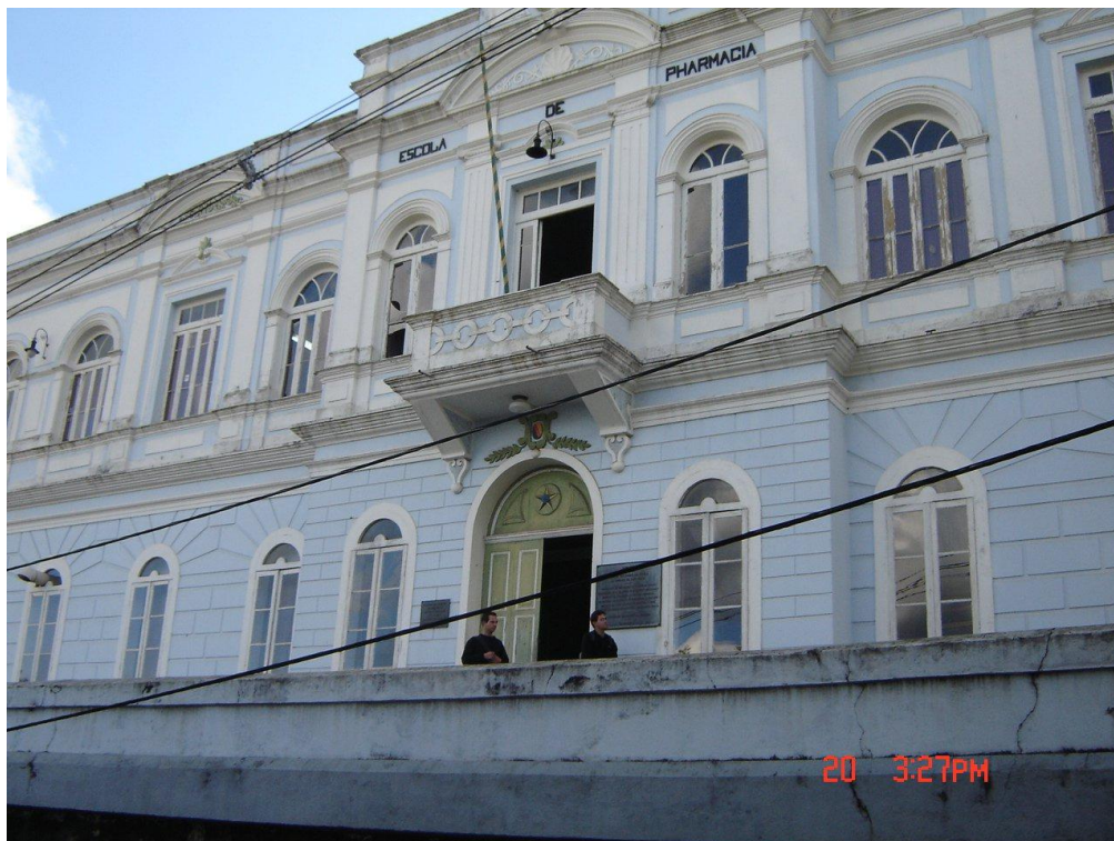
Fotografia 1 – Prédio histórico da Escola de Farmácia da UFOP
